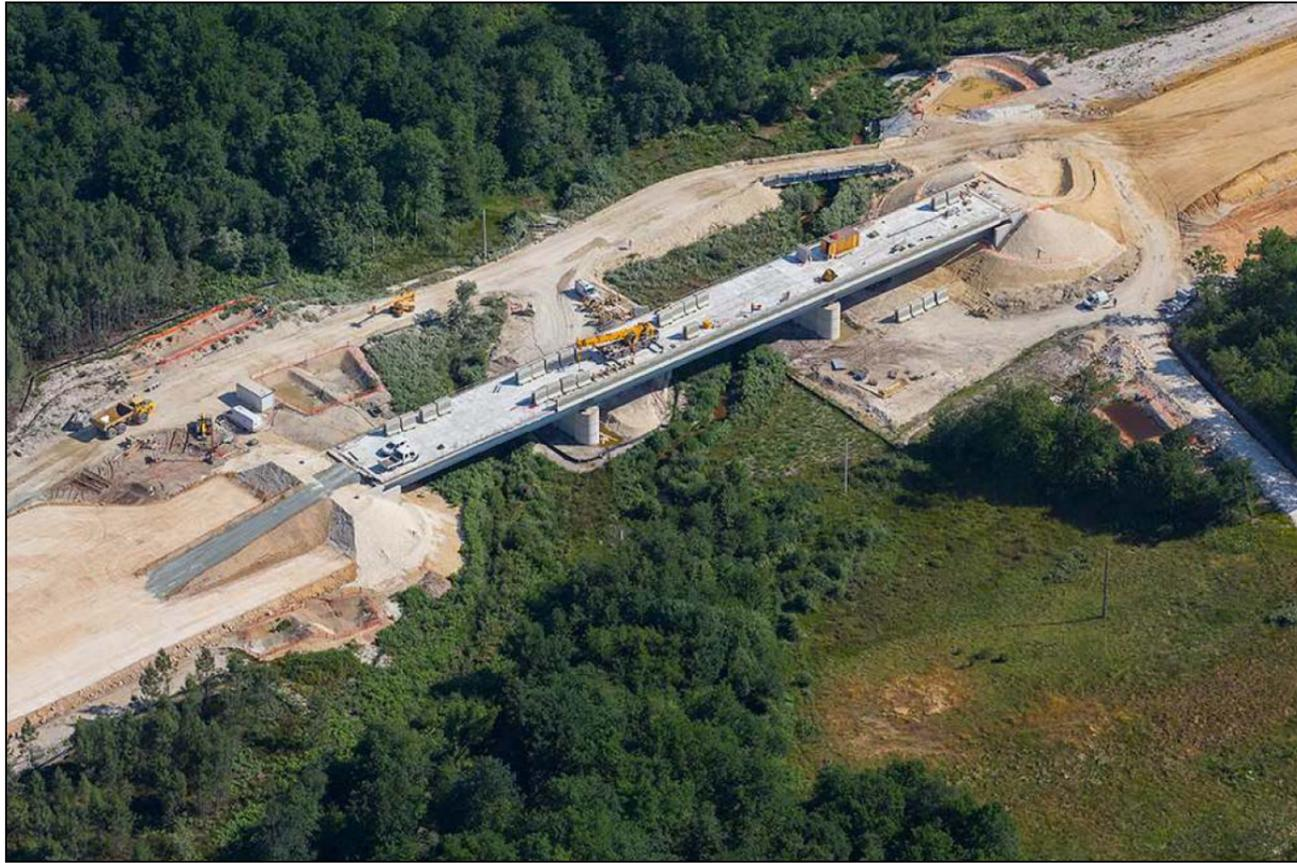
Figure 11 – Illustration d'un viaduc avec franchissement à côté par un pont provisoire
